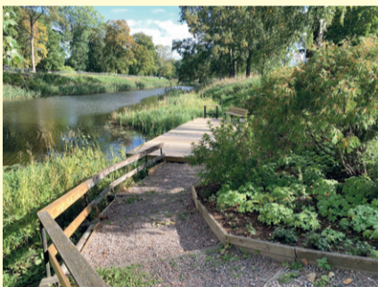
Bryggan i anslutning till Kanalparken är renoverad och rabatten är ompysslad.
